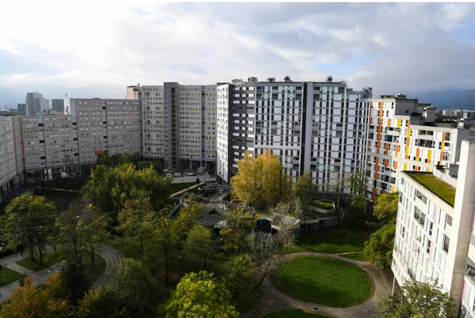
Photo prise le 24 octobre 2019 dans le quartier Arlequin, à Grenoble, où les habitants ont mis en place un RIC concernant l'avenir de certains bâtiments dont la démolition ou la rénovation est prévue. Jean-Pierre Clatot/AFP
